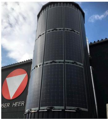
**Leicht- und Flachpaneel PV-Anlage.**
