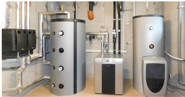
**Sole/Wasser-Wärmepumpe mit Grabenkollektorsystem sowie Trinkwarmwasseraufbereitung.**
