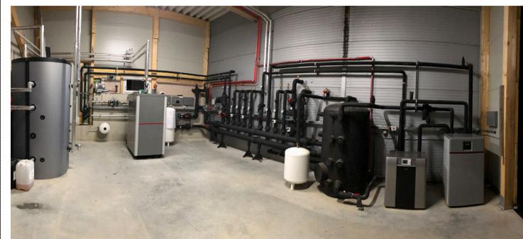
**Sole/Sole-Kälteanlage mit Eisspeichersystem und Wärmerückgewinnung.**
